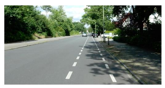
Abb. 23 Einseitige Markierung von Schutzstreifen (Osnabrück)
