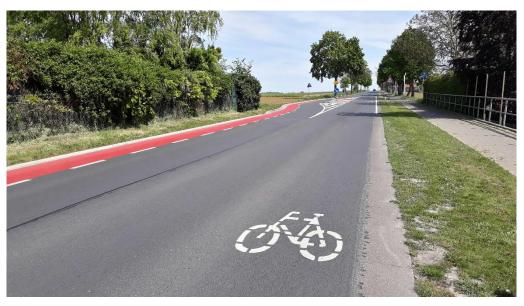
Abb. 24 Einseitige Markierung von Schutzstreifen und Markierung von Fahrradpiktogrammen auf der Fahrbahn (Seelze)
