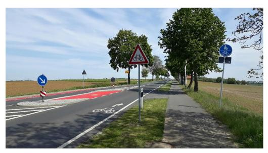
Abb. 22 Markierung von Fahrradpiktogrammen auf der Fahrbahn Übergang Fahrbahnführung innerorts und außerorts ben. RVA (Seelze)
